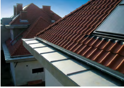
Obróbka gzymsu pod rynną
