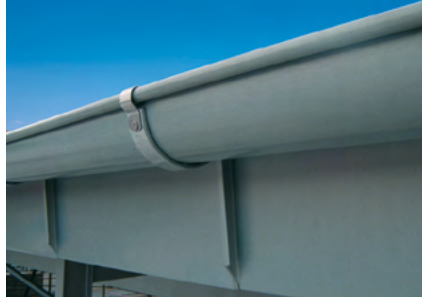
Obróbka pasa podrynnowego
