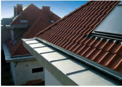
Obróbka gzymsu pod rynną
