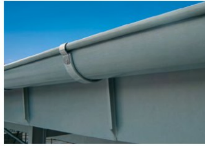
Obróbka pasa podrynnowego
